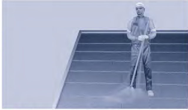
2. ควรทำความสะอาดพื้นหลังคาภายหลังมุงแล้วเสร็จ
