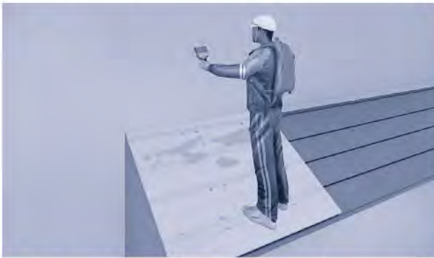
5. ก่อนเริ่มทาสีตัวอาคาร ส่วนที่อยู่เหนือหลังคาให้ทำการคลุมกระเบื้องบริเวณดังกล่าวด้วยผ้าพลาสติกหรือแผ่นไม้อัดให้เรียบร้อยก่อน เพื่อป้องกันความเสียหายที่อาจเกิดขึ้นกับแผ่นกระเบื้อง
