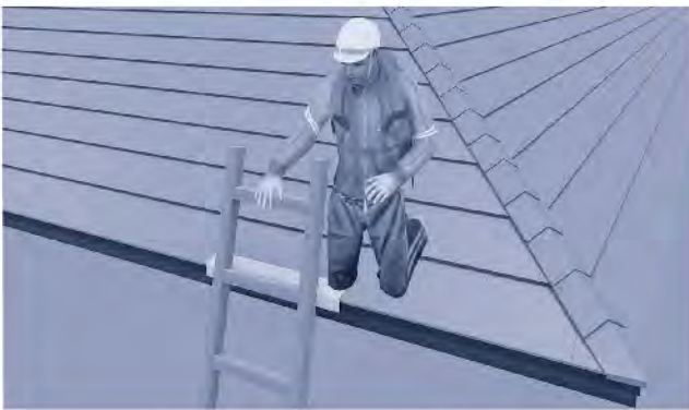
5. ก่อนเริ่มทาสีตัวอาคาร ส่วนที่อยู่เหนือหลังคาให้ทำการคลุมกระเบื้องบริเวณดังกล่าวด้วยผ้าพลาสติกหรือแผ่นไม้อัดให้เรียบร้อยก่อน เพื่อป้องกันความเสียหายที่อาจเกิดขึ้นกับแผ่นกระเบื้อง
